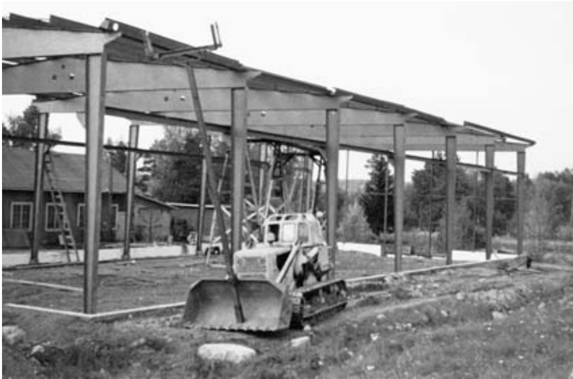
Uuden hallin rakennustyöt alkavat 1967. Kattopalkkeja nostetaan catepillarin kauhaan improvisoidulla nostimella.
